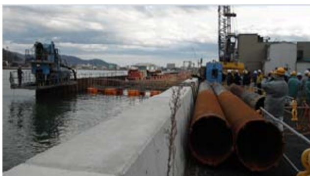
大規模な総合対策工事を見学する皆さん
